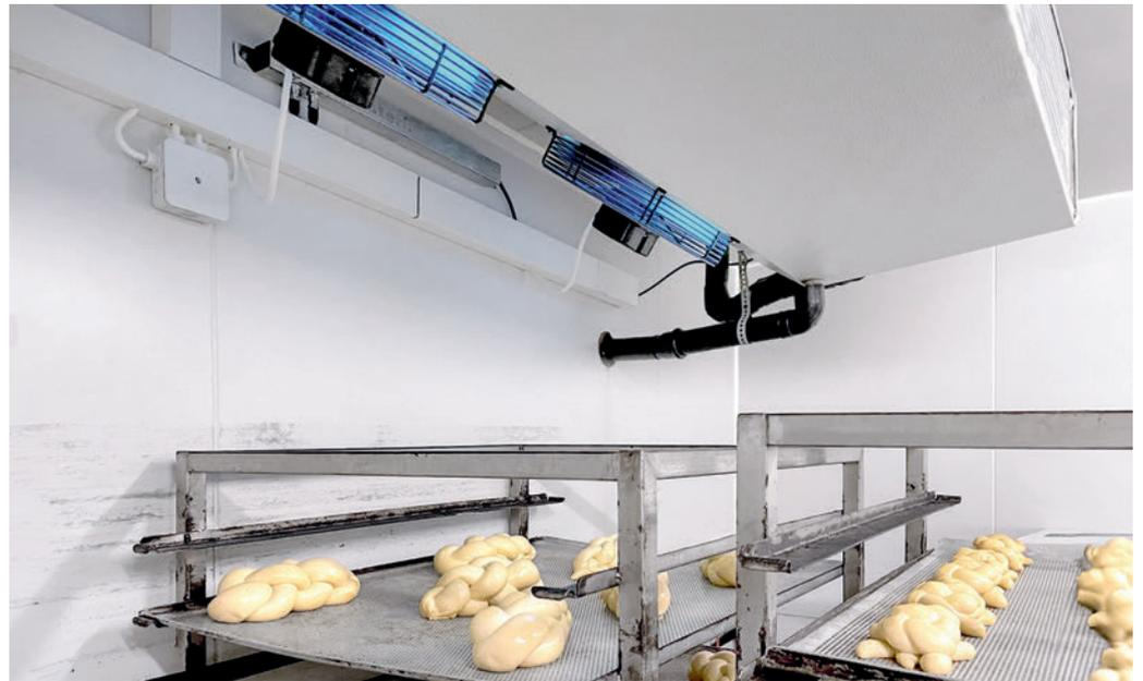
UVC-Röhren installiert. Zudem wurde der Verdampfer im Kühlraum ebenfalls mit UVC-Modulen versehen. Dank der modularen E-Serie von sterilAir gelang es, die UVC-Entkeimung in den kompakten Räumen optimal zu positionieren und eine effektive Schimmelbekämpfung zu gewährleisten.
