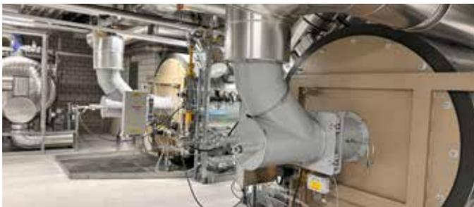
hitzekegel und danach in den LUWO. Dort ist die Vorwärmung bei beiden Brennstoffen mit max. 100°C geregelt. Aufgrund dieser optimalen Auslegung erreichen wir einen feuerungstechnischen Wirkungsgrad von > 97%!
