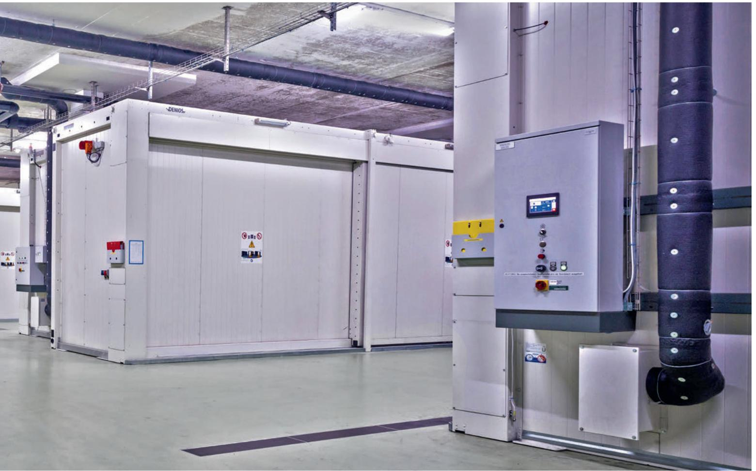
tainer von DENIOS zum Einsatz, sechs vom Typ RFP 815.30 und zwei vom Typ RFP 315.30. Diese Raumsysteme bieten geprüften und zertifizierten Brandschutz mit entsprechender ETA-Zulassung und erfüllen dadurch höchste Sicherheitsstandards.
