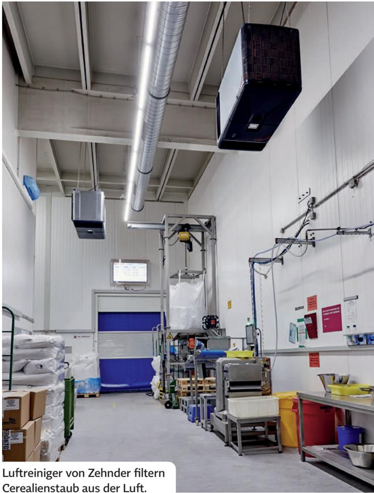
Luftreiniger von Zehnder filtern Cerealienstaub aus der Luft.
