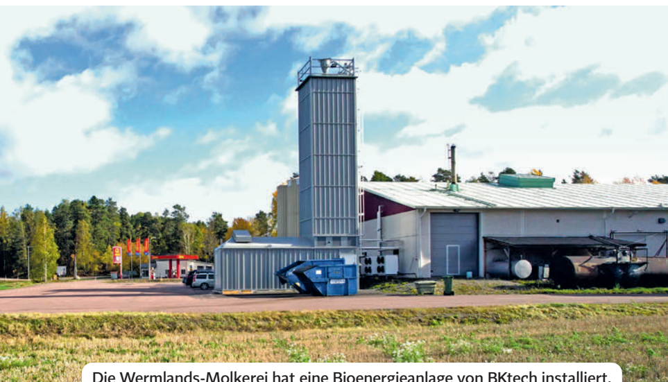
Die Wermlands-Molkerei hat eine Bioenergieanlage von BKtech installiert.
