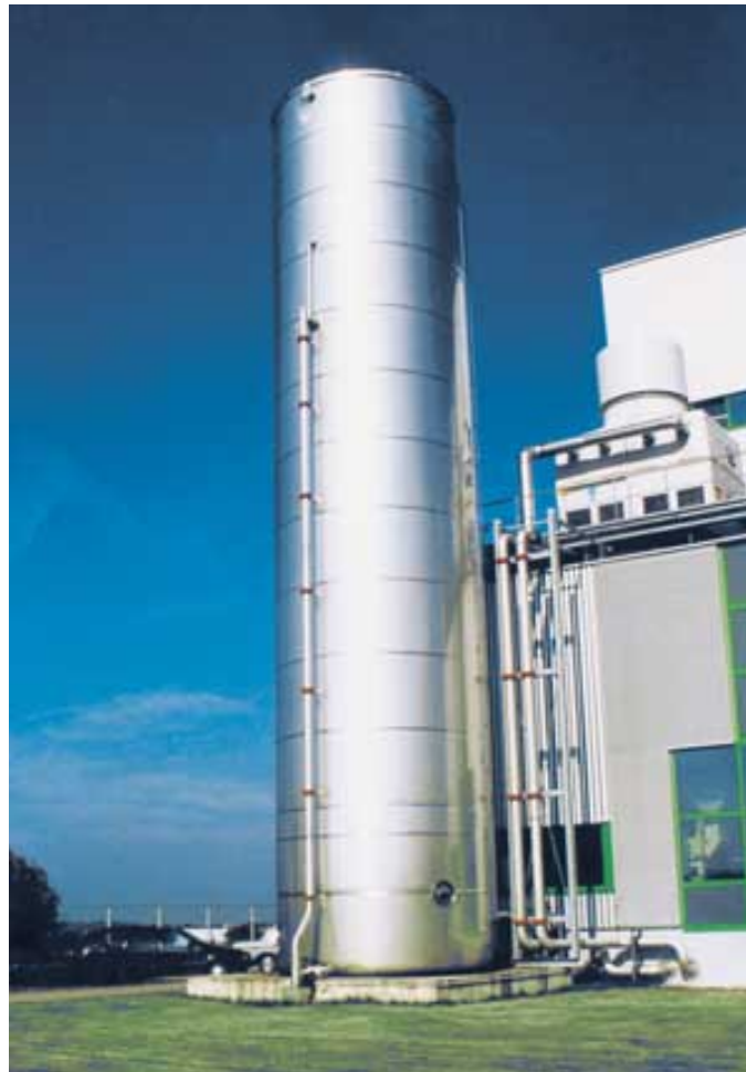
Moderner Scherbeneiswasserspeicher
